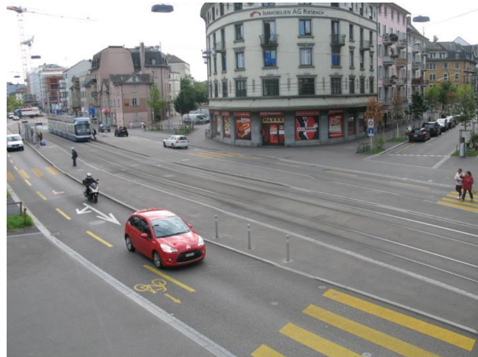
Lochergut, September 2013: Umbau Tramhaltestelle, Aufhebung Einbahnregime und Velomassnahmen Badenerstrasse, Abbruch Barriere für Nachtspernung Weststrasse, Ersatz mit permanenter Sperre
