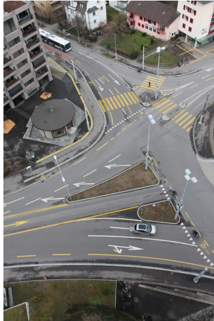
Triemli, März 2014: Busspur bei Knotenzufahrt, Vortrittsänderung (Stadtzufahrt neu vortrittsbelastet), zusätzlicher Fussgängerstreifen, Velomassnahmen
