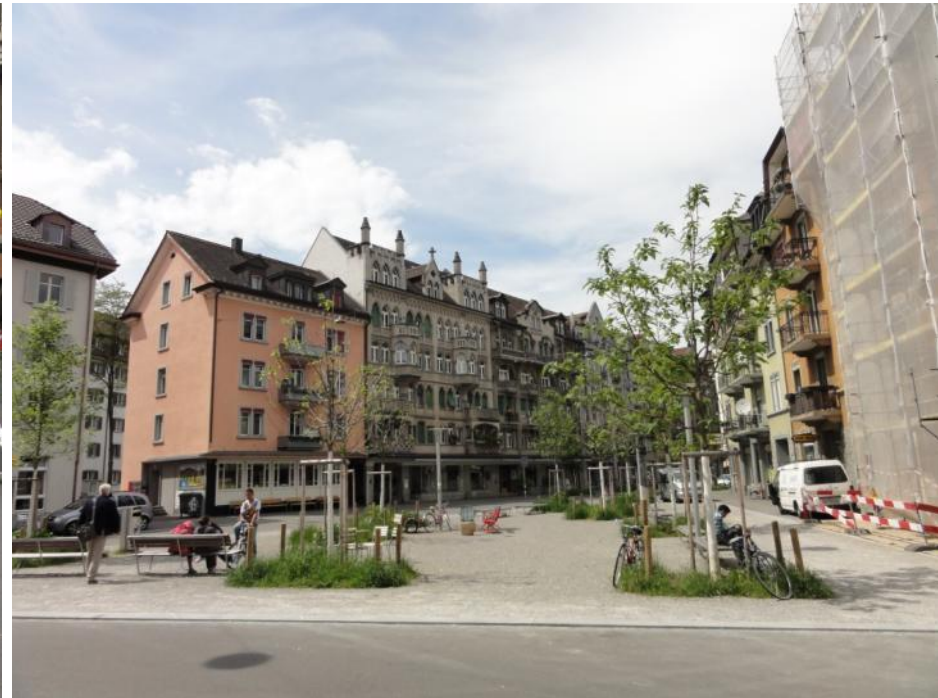
Brupbacherplatz, Mai 2013: Umbau der Strassenkreuzung West-/Gertrudstrasse zu einem Platz, Wegfall der Fahrbahn auf der Ostseite, neue Gestaltung mit Bäumen und Bänken
