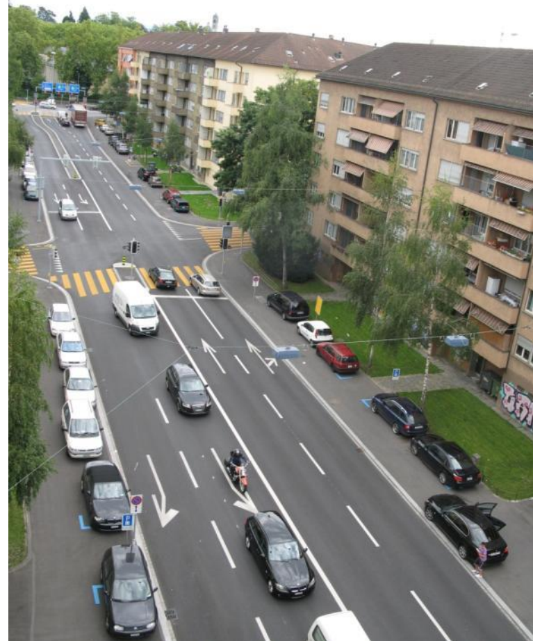
Schimmelstrasse, September 2010: Gegenverkehr, Verlagerung Transitverkehr auf Westumfahrung, Fussgängerstreifen neu mit Schutzinsel ausgerüstet
