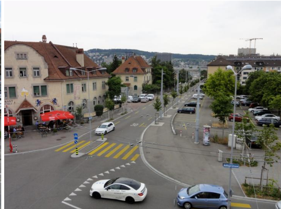
Knoten Herdern-/Bullingerstrasse, August 2013: Umbau zu einem Knoten ohne Lichtsignalanlage, Umbau Herdernstrasse zu verkehrsberuhigter Quartierstrasse mit Tempo 30 und Kernfahrbahn,
