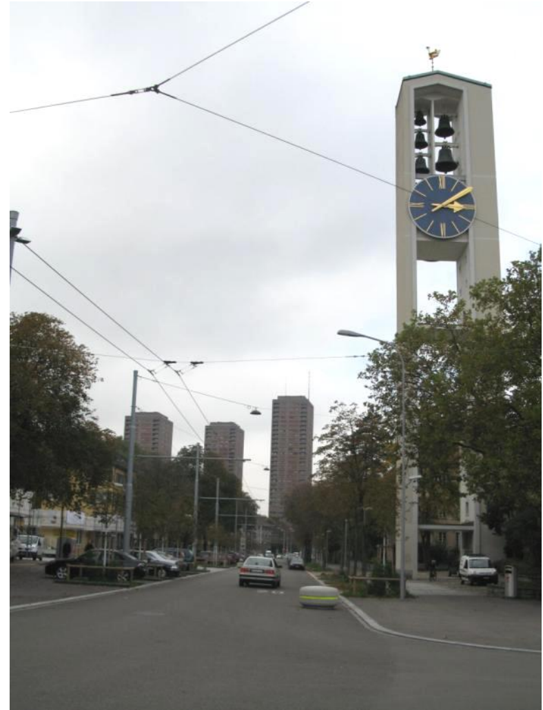
Bullingerstrasse, Oktober 2012: Tempo 30, Gegenverkehr, Abbruch Fussgängerüberführung
