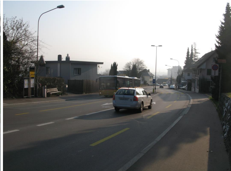
Birmensdorferstrasse, März 2014: Neuer Fussgängerübergang, Fortsetzung Velostreifen stadteinwärts, Busspur in Fahrtrichtung stadtauswärts
