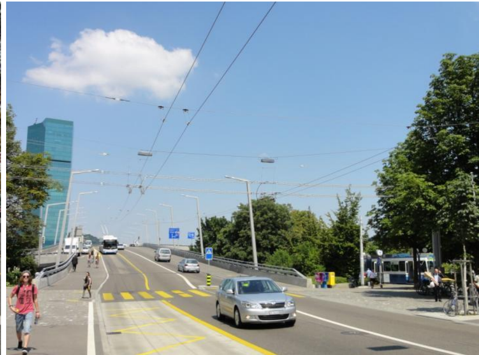
Hardstrasse, August 2013: Neuer Fussgängerstreifen Bushaltestelle Hardplatz, sanierte Hardbrücke
